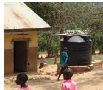
Pendant la saison des pluies, les eaux de ruissellement des toits sont récoltées et conservées dans une citerne.
